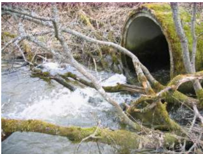
Figur 3-19 Finstadbekken ved Våler. Vierkratt i bekkeløpet.
