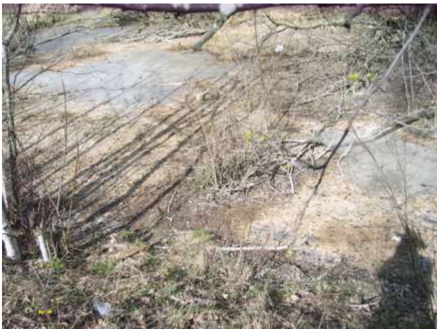
Figur 3-37 Kalkdam ved Slorabanen
