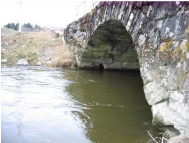
Figur 3-26 Losbyelva ved Hammer Bru
