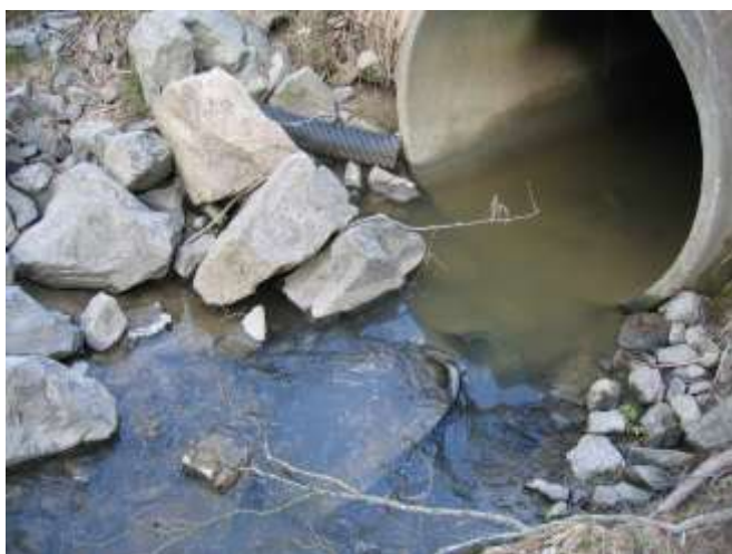
Figur 3-21 Bårlibekken ved Gamleveien. Ved utløpet av kulverten.
